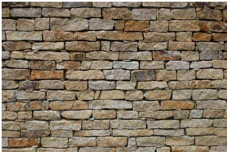
Les matériaux à maçonner proviendront de carrières granit et seront de couleur beige. Ils seront utilisés bruts et retaillés sur place au moment de l'élévation des murs en ayant soin d'obtenir une surface plate.
