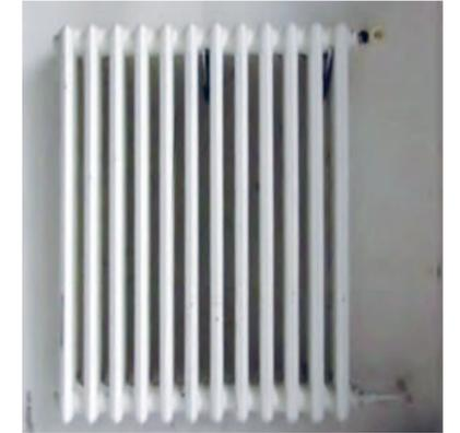
Réemploi des radiateurs en fonte en pièces principales des logements
