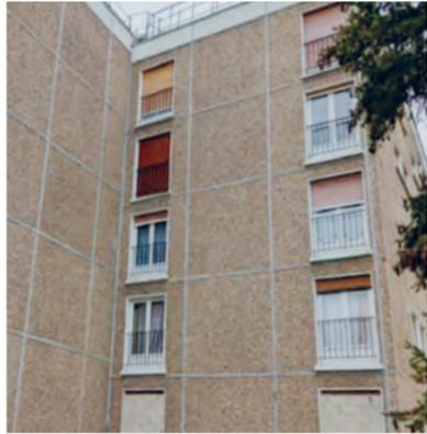
Panneaux de façade préfabriqués en béton conservés après déconstruction.
