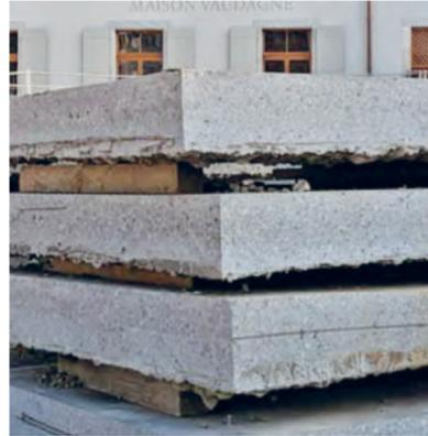
Stockage des Panneaux en béton issus de la déconstruction pour Réemploi
