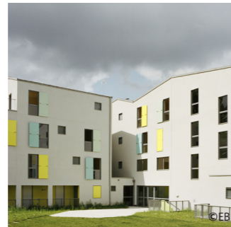
33 LOGEMENTS BIOCLIMATIQUES - ORLÉANS Foncière logement + Cirmad livré en 2011 - P.Chemetov+B.Fleury
