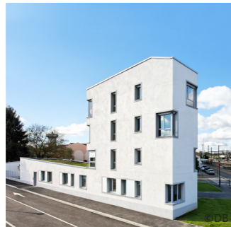
MAISON RELAIS, 24 LOGEMENTS - RAMBOUILLET SOGEMAC HABITAT livré en 2013
